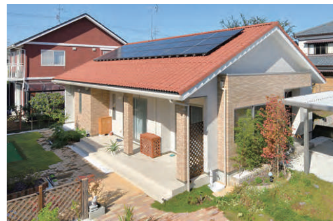
▲太陽光発電システムを約5.0kW搭載しているM様邸。最高で収支が14,000円ほどプラスになったこともあるそう。
